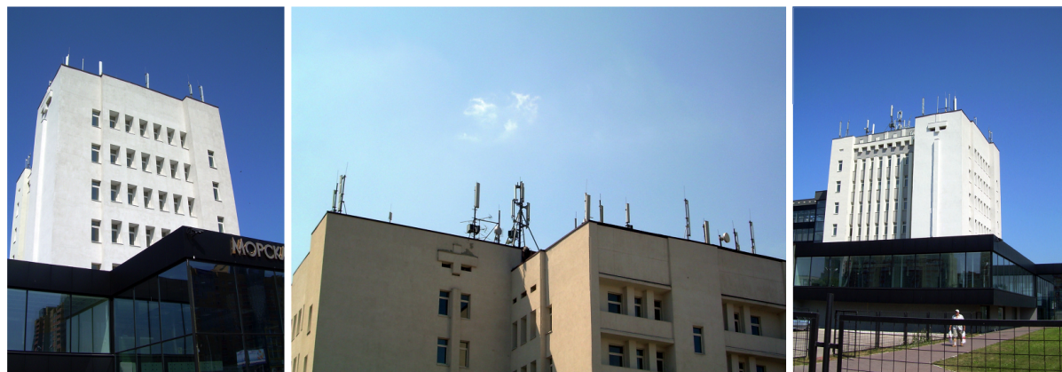
Рисунок 14 – Антенны БС и РРС на кровле здания (общий вид)
