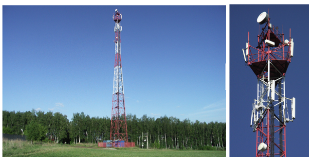
Рисунок 17 – Общий вид и размещение антенн БС на башне Основные технические характеристики БС под условными наименованиями № 1 и № 2 приведены в таблицах 9 и 10 соответственно.
