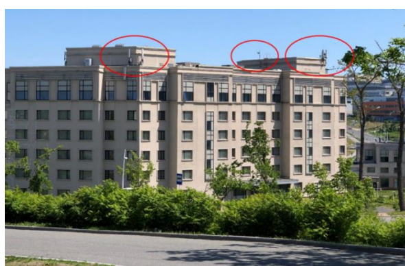
Рис. 11. Базовые станции на корпусе № 4
