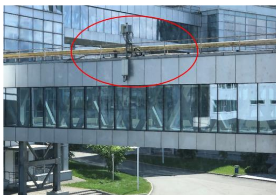
Рис. 7. Расположение ПРТО на переходе корпуса Е
